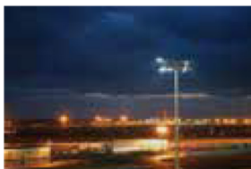
Sites industriels et de construction
